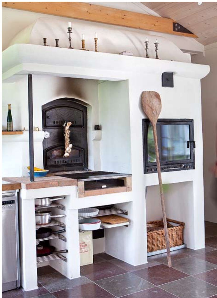
Eldstaden och bakugnen är murad på traditionellt vis av ugnsmurarmästare Johannes Riesterer. När de eldar i den inmurade spisinsatsen får de värme till golvvärmeslingorna.
