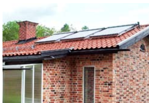
Den breda takfoten skyddar huset. Solfångare på taket ger varmvatten.
